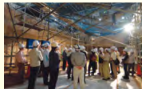
工事用の足場に覆い尽くされている大ホールのステージ
