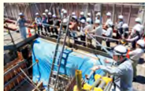
中ホールに設置工事中的エレベーター
